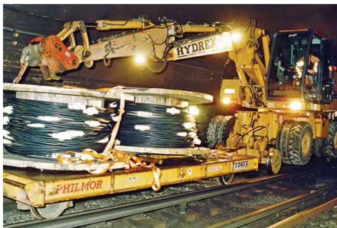
Установка запасного (аварийного) подземного освещения
