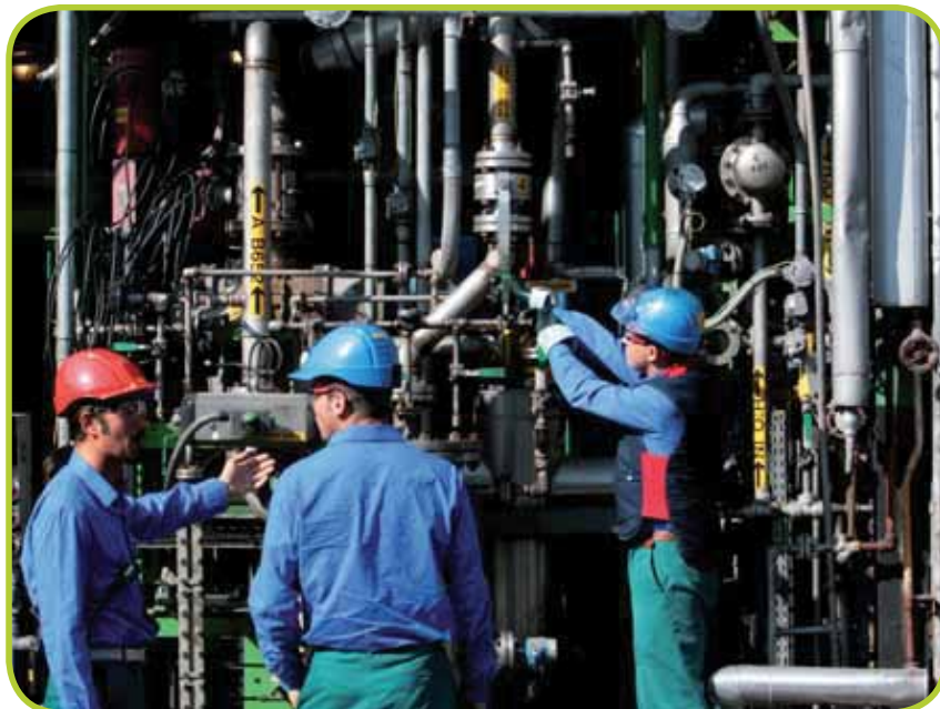
Операторы на объекте
